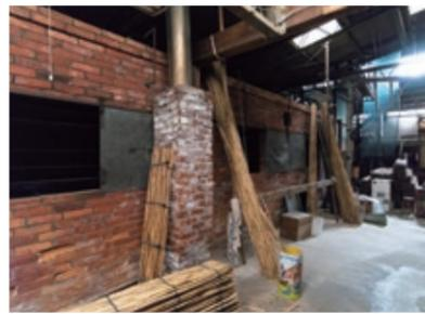
[Fig.3-2-1-2] 茶工場の煉瓦造碾茶乾燥炉
